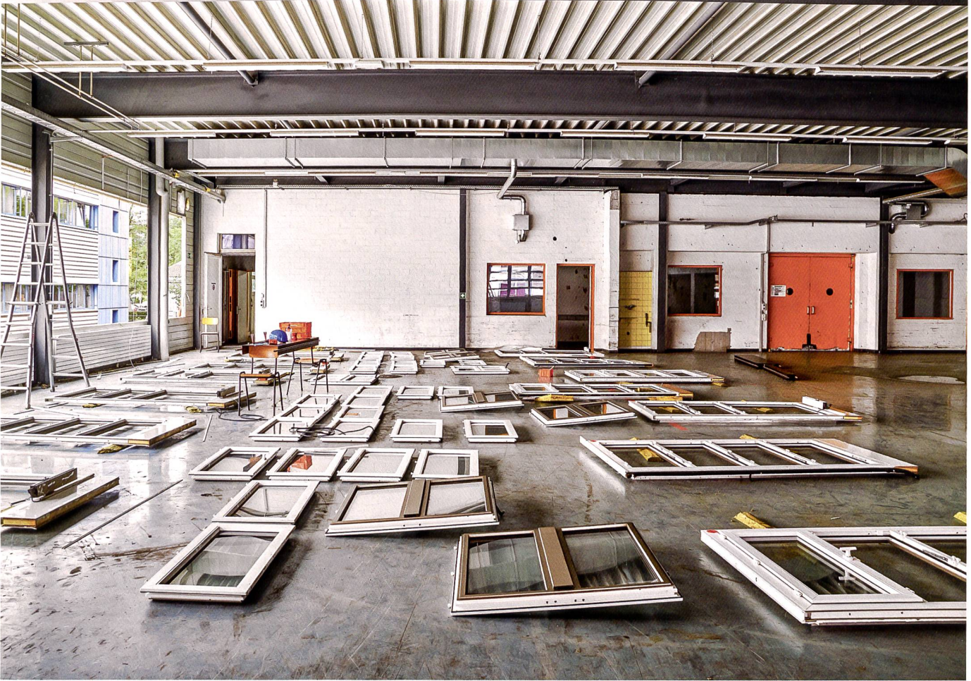
Fenster aus einem verlassenen Druckereibetrieb warten auf die Neunutzung bei der Aufstockung der Industriehalle 118 in Winterthur.
