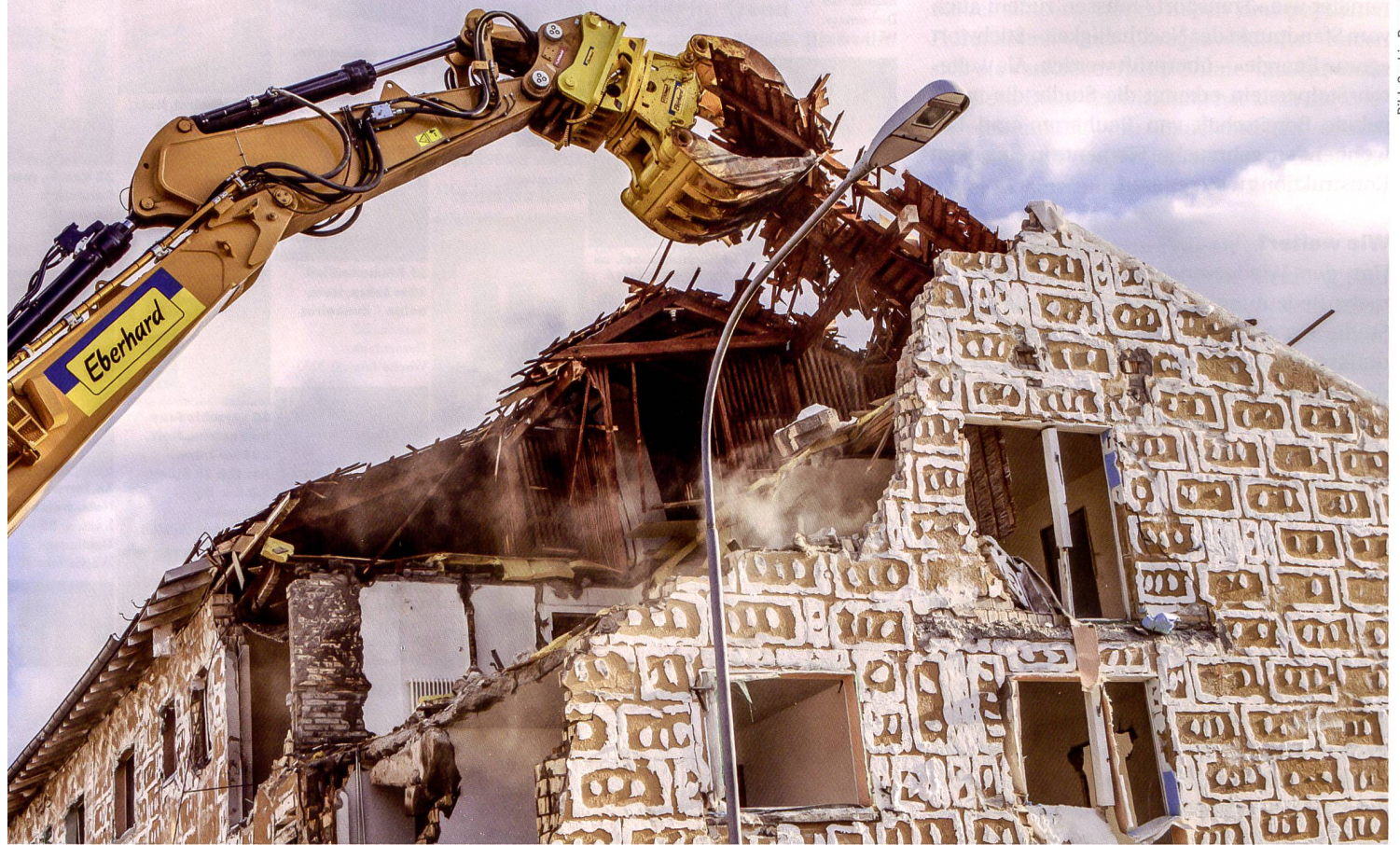
Die Baugenossenschaft Frohheim stellt zurzeit die zweite Etappe der Ersatzneubausiedlung Brüderhofweg in Zürich mit insgesamt 260 Wohnungen und verschiedenen Zusatznutzungen wie Restaurant oder Kita fertig. Dafür war der Rückbau von 29 Altliegenschaften notwendig. Bild: Demontage von Dachaufbauten der bereits entkernten und schadstoffsanierten Gebäude. Zum Einsatz kam ein 100-Tonnen-Bagger.
