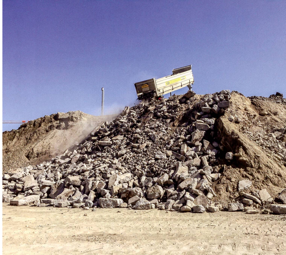
Der Misch- und Betonabbruch vom Brüderhofweg wurde im Baustoff-Recycling-Zentrum «EbiREC» in Rümlang (ZH) aufbereitet, in der Mitte die Brecher-, ganz rechts die Betonmischanlage.
