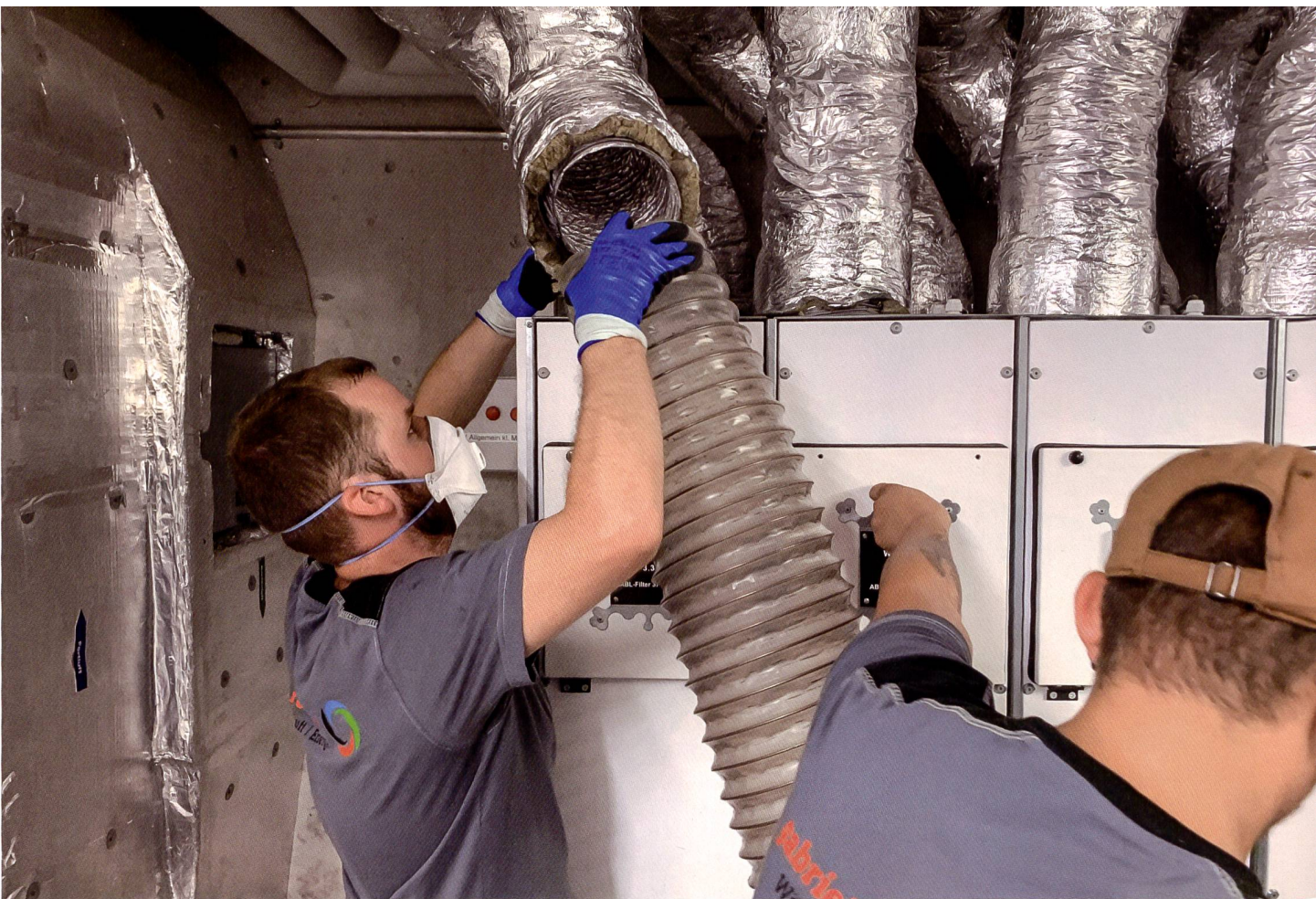
Bei einer professionellen Reinigung der Lüftungsanlagen werden die Ablagerungen in den Rohren abgesaugt und die Filter gewechselt.
