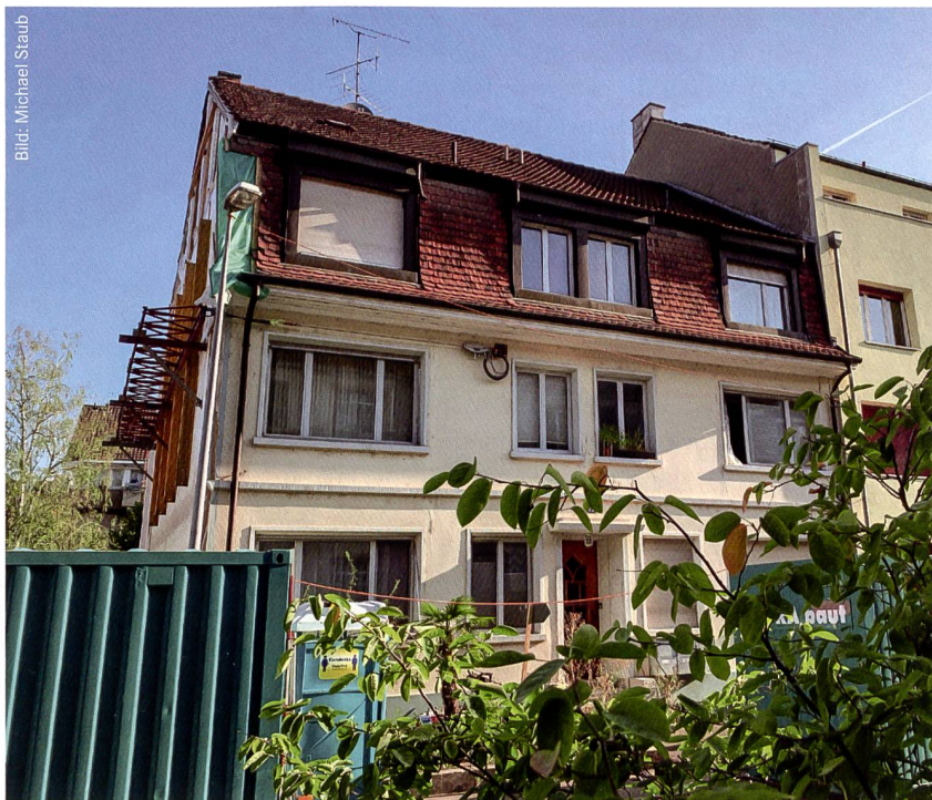
Im Wohnhaus von 1932 in Basel läuft das vielversprechende Pilotprojekt der Industriewerke Basel (IWB). Es konnte rasch und einfach umgerüstet werden; die bisherige Wärmeverteilung samt Heizkörpern ist weiter nutzbar.
