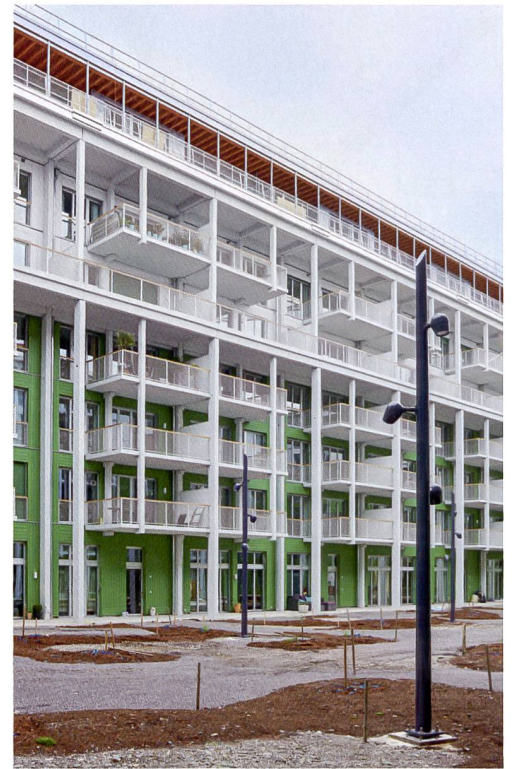
Ein Grossteil des Gemeinschaftslebens wird im 2000 Quadratmeter grossen Innenhof stattfinden. Hier ist ersichtlich, dass der Bau zu grossen Teilen aus vorgefertigten Holzelementen besteht.
