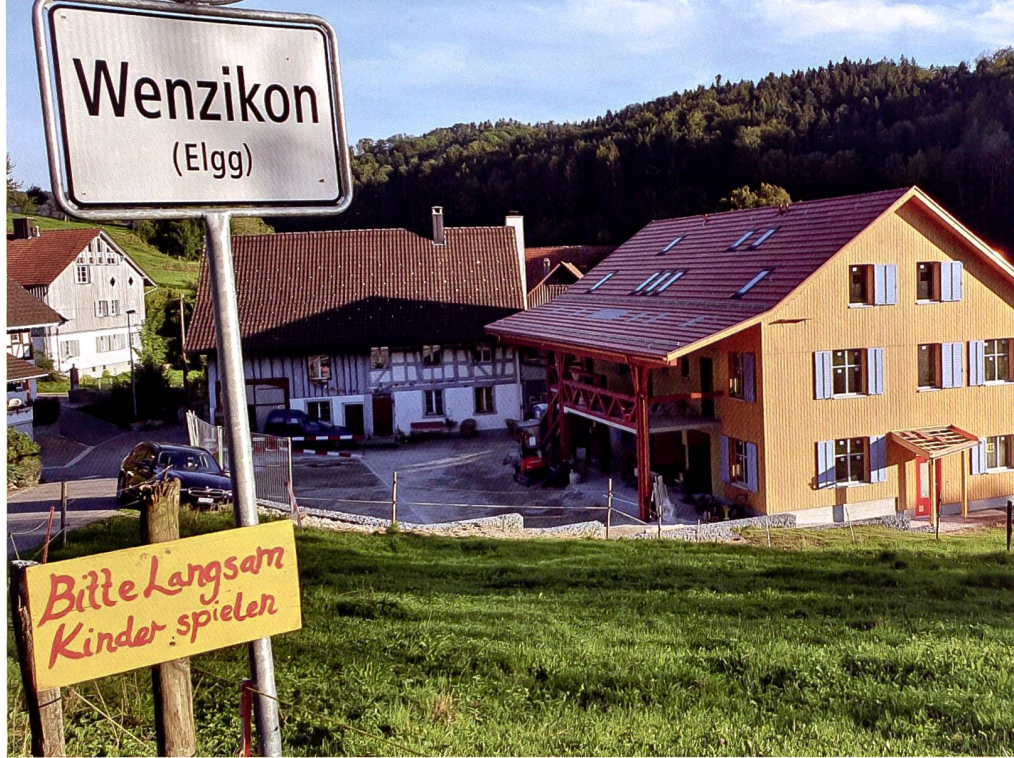
Im Weiler Wenzikon hat die WAK Elgg ihren zweiten Neubau errichtet. Die vier Familien, die hier im Oktober 2020 eingezogen sind, teilen sich einen Gemeinschaftsraum, Büro und Garten.
