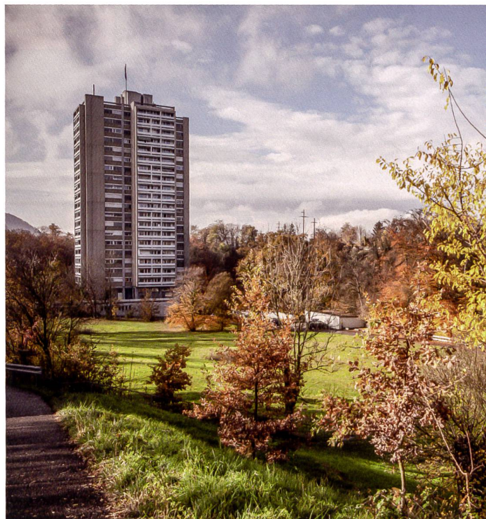
Brisgi-Areal heute mit Blick auf das bestehende Hochhaus.
