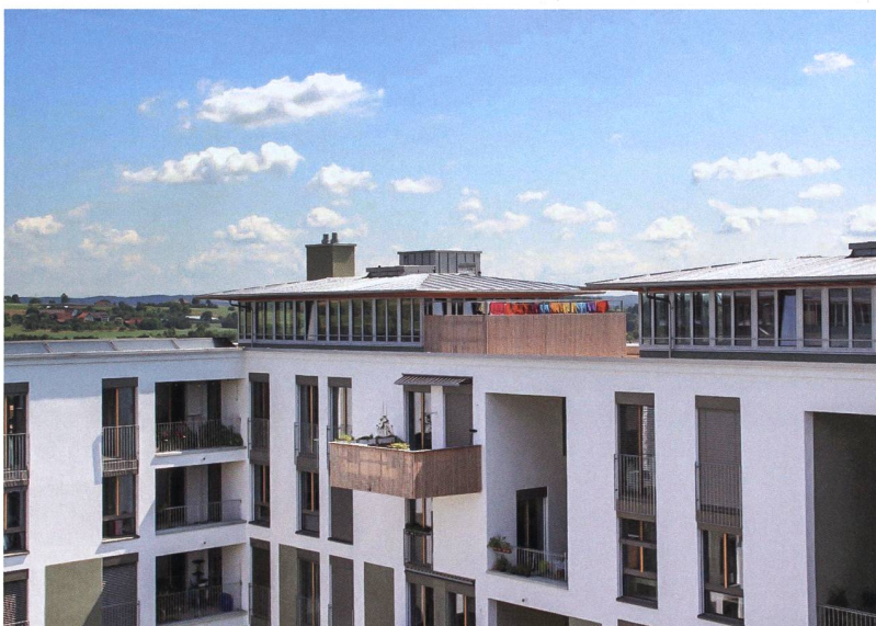
Die GBMZ setzte in der Siedlung Klee dagegen auf Waschpavillons auf den Dächern. Die angrenzende Terrasse wird zum Wäschetrocknen und Verweilen genutzt.
