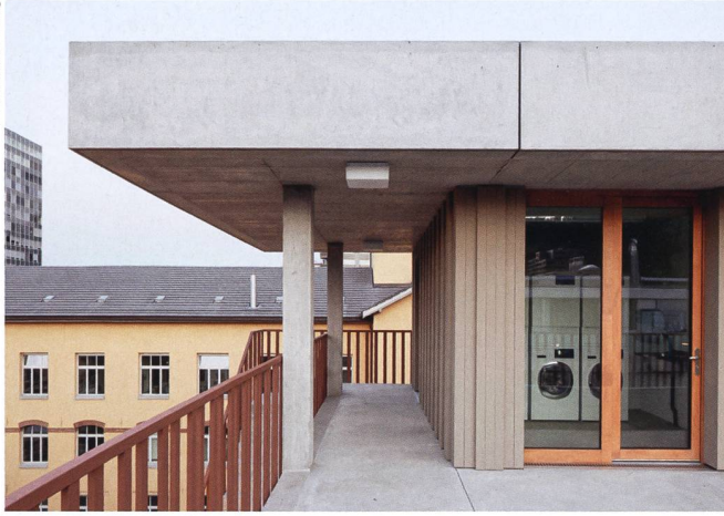
Nicht alltäglich sind auch die Waschsalone von Wohnen Lägern in ihrer Siedlung Gartenstrasse in Baden (AG).
