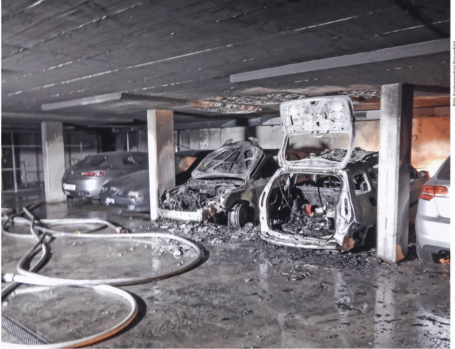
Brandereignisse in Tiefgaragen haben oft verheerende Folgen. Bild: Polizeiaufnahme eines Brandereignisses in Frauenfeld von 2018. Es entstand ein Sachschaden von mehreren Hunderttausend Franken.
