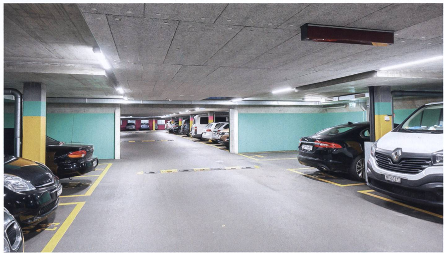
Situation vorher (oben) und nachher.
