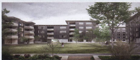
Das Ersatzneubauprojekt Klosterbrühl in Wettingen hat sich aus verschiedenen Gründen verzögert. Der Baustart für die rund 230 Wohnungen könnte frühestens 2023 erfolgen.
