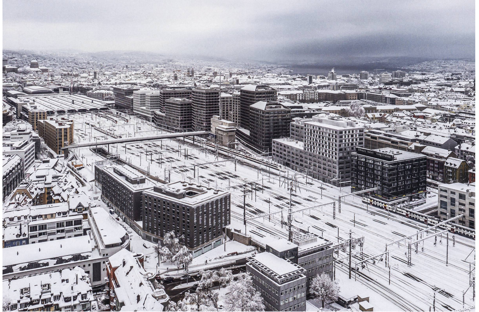
Das Zollhaus bildet einen Gegenpol zur kommerziellen Europaallee auf der anderen Seite der Gleise.
