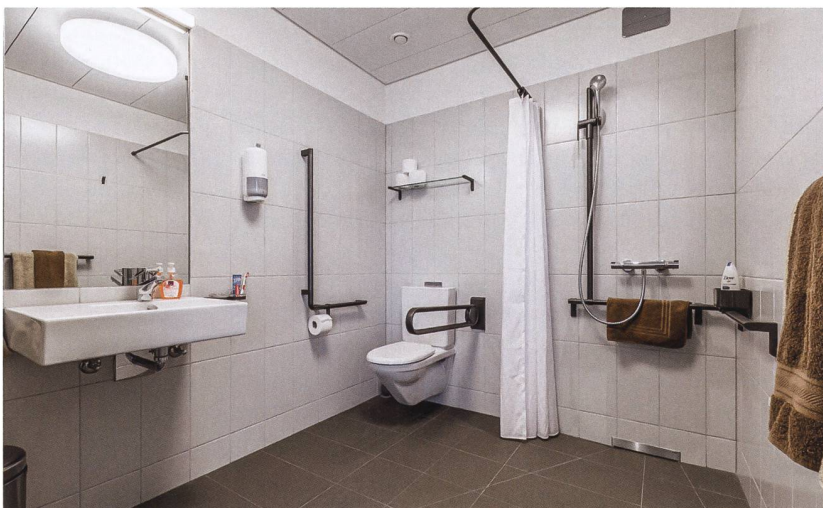
Der Wohnraum in der Casa Giesserei ist schwellenfrei und rollstuhlgängig eingerichtet.
