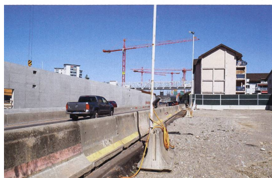
Manche Häuser mussten bereits abgebrochen werden, um Platz für den Bau und die Installationen zu schaffen, so bei der BG Süd-Ost oder der BG Glattal.
