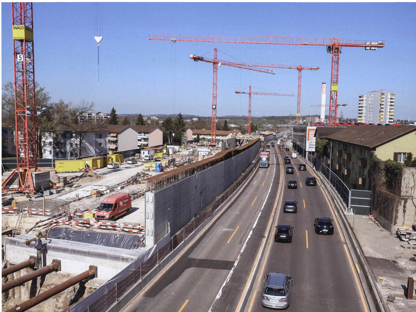
Stand der Einhausung Schwamendingen im Frühling 2021: Die Arbeiten sind in vollem Gange, die Mittelwand des Tunnelbauwerks bereits erstellt.
