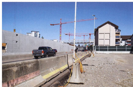
Manche Häuser mussten bereits abgebrochen werden, um Platz für den Bau und die Installationen zu schaffen, so bei der BG Süd-Ost oder der BG Glattal.
