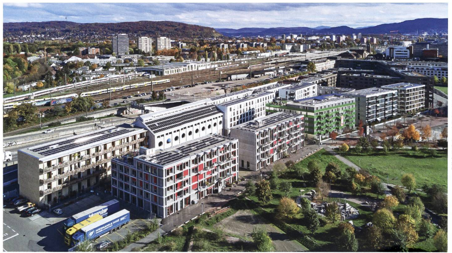
Die Bauten im Quartier Erlenmatt Ost in Basel sind zur bisher grössten Eigenverbrauchsgemeinschaft der Schweiz verbunden. Photovoltaik auf den Dächern liefert Strom für die Wärmepumpen und deckt einen Teil des übrigen Strombedarfs.
