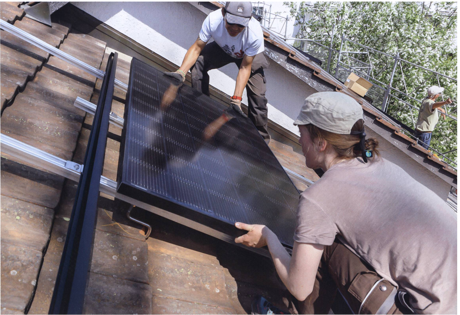
Unter fachkundiger Anleitung können auch Laien Solarmodule sicher und korrekt anbringen.
