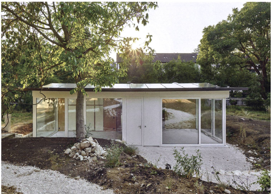
Beim «Movable House» in Basel experimentierten Rhabaran Hürzeler Architektinnen mit Phasenwechsel-(PCM-)Speichersystemen: Vor dem Betonieren wurden PCM-Module aus Salz (blau) und aus Wachs (grün) eingesetzt. Dank diesem platzsparenden Heizungs- und Kühlsystem im Boden konnte das Gebäude in Leichtbauweise erstellt werden.
