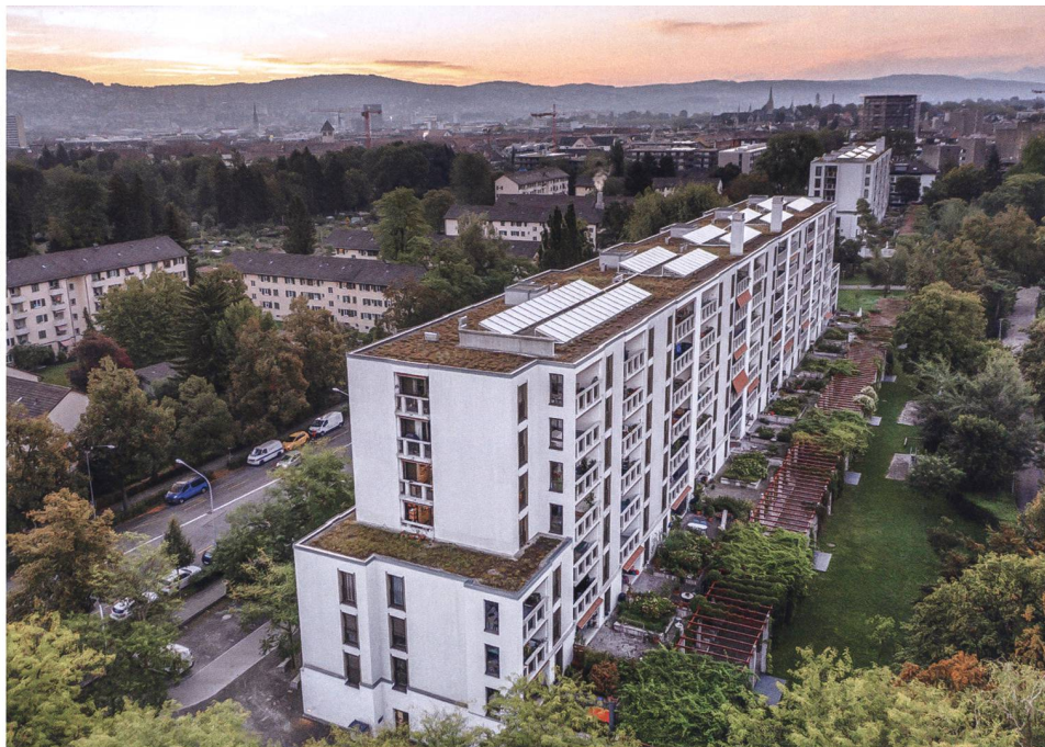
Vor einigen Jahren hat die BiG an der Gutstrasse ihre ersten Ersatzneubauten erstellt (Bildmitte). Sie wird ihre weiteren Gebäude im Quartier (ein Teil davon vorne links im Bild) etappenweise ebenfalls ersetzen und die Neubauten mit Gebäudeautomationssystemen ausstatten.
