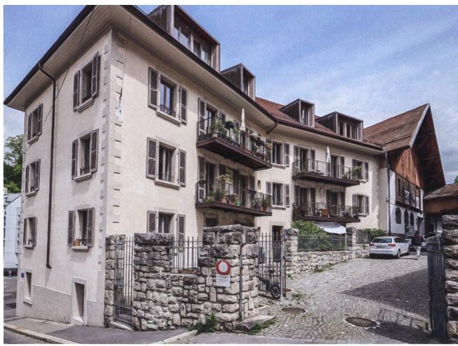
Die Fassade des historischen Gebäudes wurde in den Originalzustand zurückversetzt. Im Inneren bietet es heute modernen Wohnkomfort.
