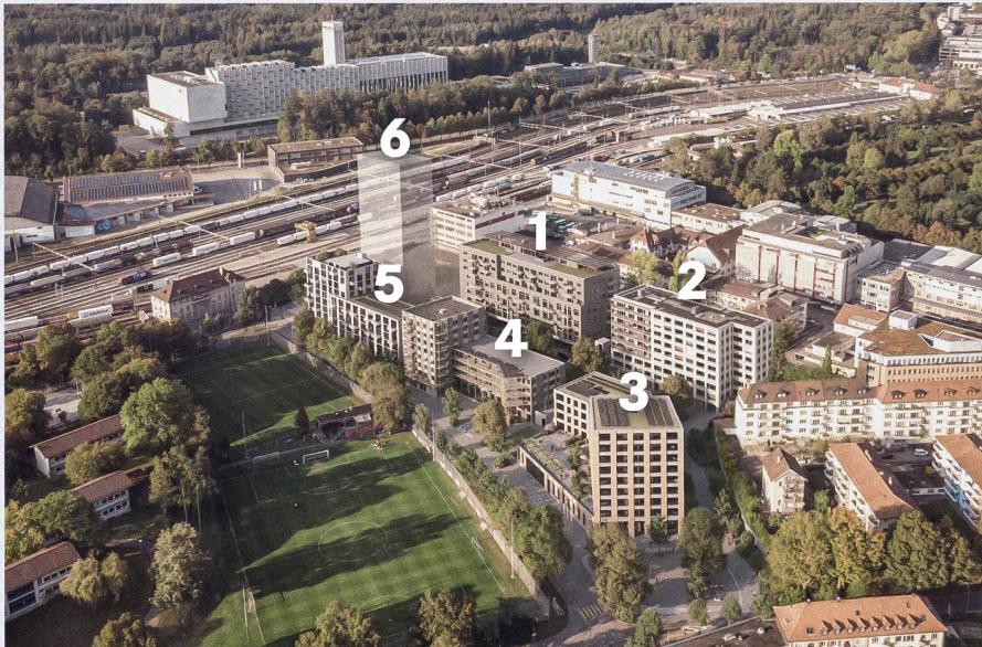
Übersichtsplan der Siedlung Holliger, die bis 2026 entsteht. Sie umfasst fünf Neubauten und das alte Lagerhaus der Chocolat Tobler.
