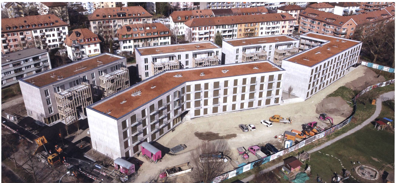
Die fünf Gebäude der Huebergass sind dicht gebaut und bilden zusammen eine innenhofartige Gasse.
