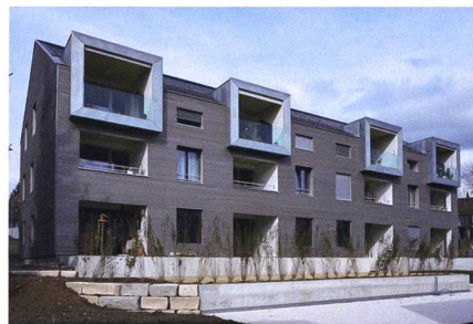
Bei ihrem ersten Ersatzbau nach über fünfzig Jahren konnte die Biwog in Brüg dringend benötigten Wohnraum für ältere Menschen schaffen.
