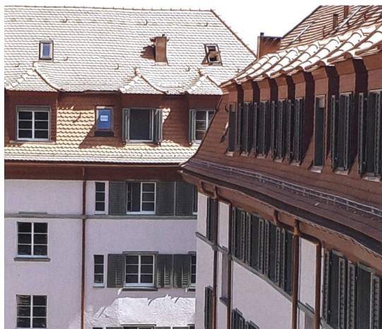
Die Denkmalpflege legte grossen Wert auf den Erhalt der Dachkonstruktion und die Gestaltung der Lukarnen. Diese mussten allesamt detailgetreu erneuert werden.
