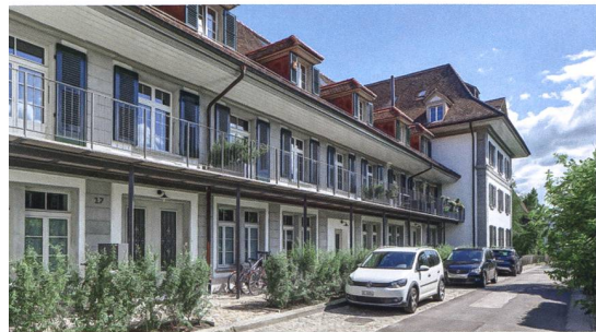
Rückseite: Mit Einverständnis der Denkmalpflege wurde im ersten Stock eine Balkonzeile ergänzt. Sie fügt sich unauffällig ins historische Bild ein.
