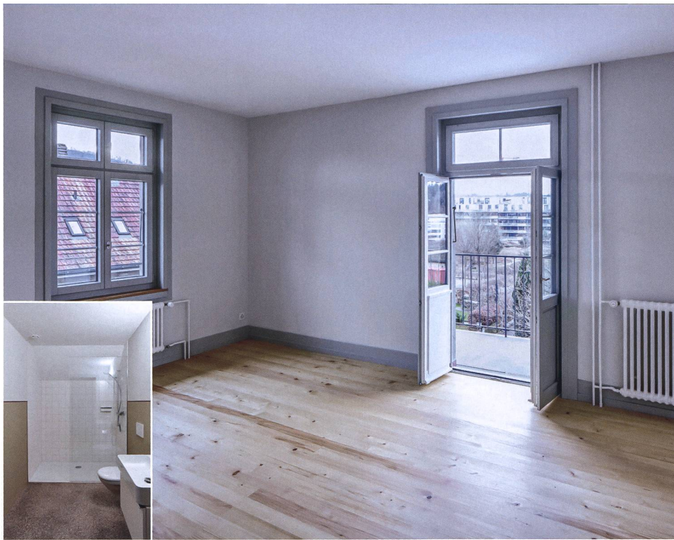
Die vorhandenen Alterswohnungen wurden umgebaut. Dabei beliess man die Raumstrukturen der Drei- und Vierzimmerwohnungen, machte sie aber barrierefrei. So sind die vergrösserten Balkone schwellenfrei zugänglich, die Bäder wurden mit bodenebenen Duschen ausgestattet.
