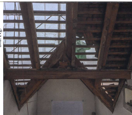
Bei Planung und Umbau kamen im Dach Holzbauten zum Vorschein, die zum Teil aus dem 18. Jahrhundert stammen. Man versuchte, sie zu erhalten und die Wohnungsrisse anzupassen. Manche Holzverstrebungen waren aber morsch und mussten ersetzt werden.
