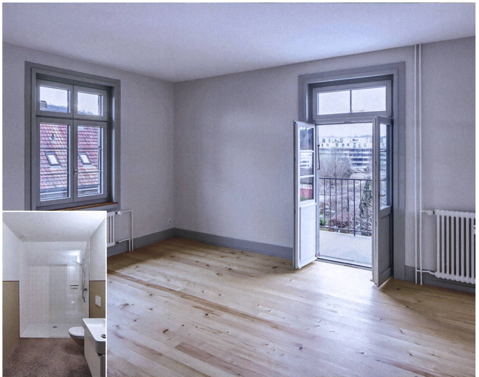
Die vorhandenen Alterswohnungen wurden umgebaut. Dabei beliess man die Raumstrukturen der Drei- und Vierzimmerwohnungen, machte sie aber barrierefrei. So sind die vergrösserten Balkone schwellenfrei zugänglich, die Bäder wurden mit bodenebenen Duschen ausgestattet.
