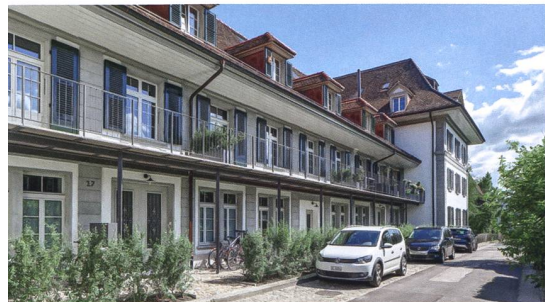
Rückseite: Mit Einverständnis der Denkmalpflege wurde im ersten Stock eine Balkonzeile ergänzt. Sie fügt sich unauffällig ins historische Bild ein.
