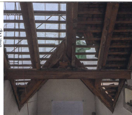
Bei Planung und Umbau kamen im Dach Holzbauten zum Vorschein, die zum Teil aus dem 18. Jahrhundert stammen. Man versuchte, sie zu erhalten und die Wohnungsrisse anzupassen. Manche Holzverstrebungen waren aber morsch und mussten ersetzt werden.
