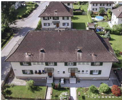
Sieben Einzel- und zwei Doppelhäuser bilden das Gartenstadt-Ensemble. Es steht unter Ortsbildschutz.
