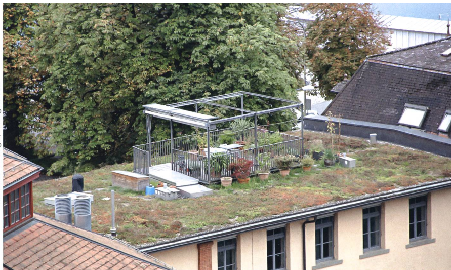
Auch auf älteren Gebäuden lassen sich Dächer als luftige Oasen nutzen – hier ein Beispiel aus dem Berner Marziliquartier. Wenn die Dächer bepflanzt werden, heizen sie sich im Sommer nicht so stark auf.
