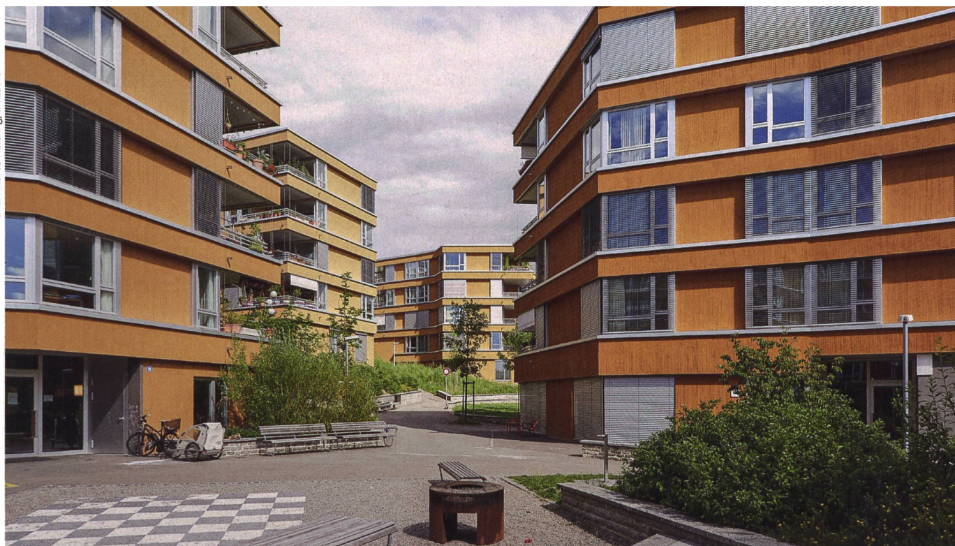
Zu den refinanzierten ABZ-Siedlungen zählt auch die an der Toblerstrasse in Zürich. Mit der Anleihe konnte die ABZ 120 Millionen Franken am Markt platzieren; weitere Anleihen zieht die ABZ in Erwägung, sobald sie wieder baut und einen höheren Fremdkapitalbedarf hat.
