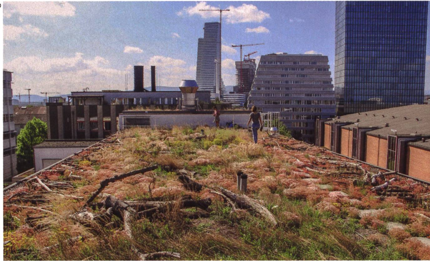
Der Verein Dachbegrünung Region Basel führt Dachbegrünungen und -aufwertungen durch – im Bild ein Gebäude an der Mattenstrasse.
