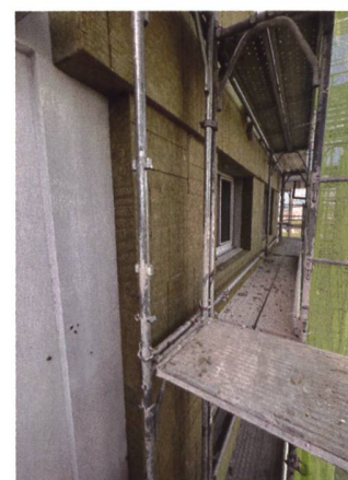
Die gesamte Gebäudehülle sowie die Fenster wurden energetisch saniert. Die Fassade wurde mit Mineralwolle gedämmt.
