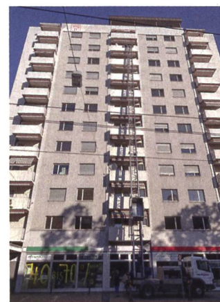
Eine Herausforderung war die Organisation der Umzüge. Dank einem Fassadenlift bewältigte das Zügelunternehmen drei bis vier Wohnungsumzüge pro Tag.
