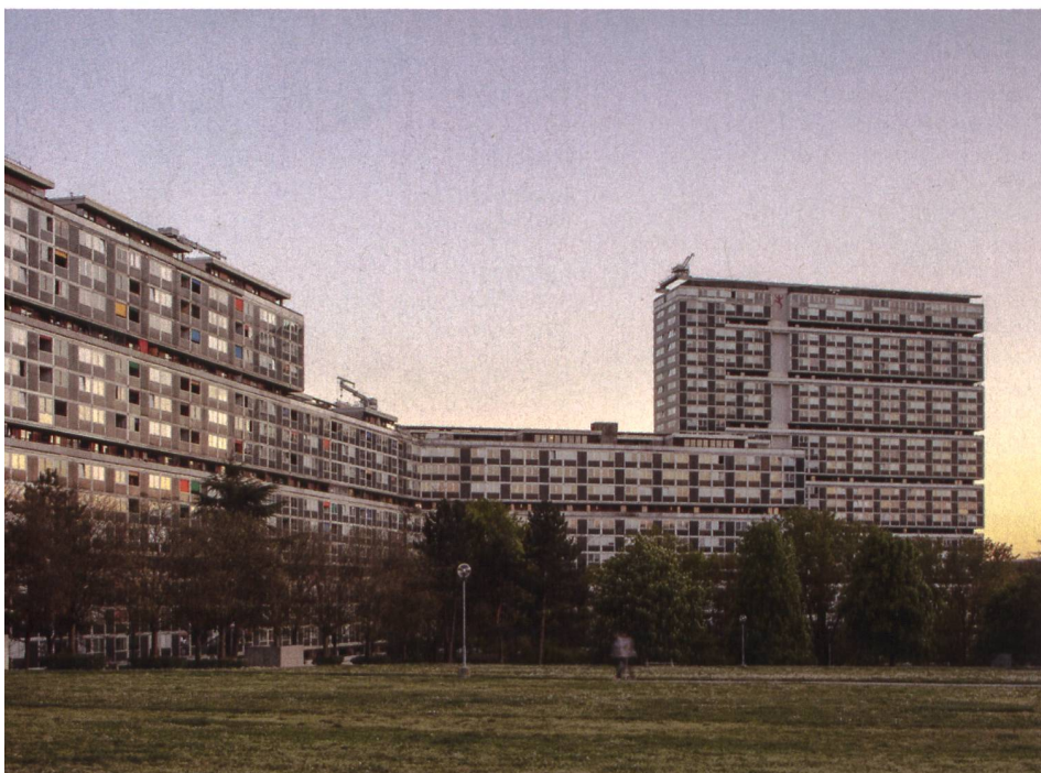
Unsichtbare Grossleistung: Die Renovation der Fassaden war planerisch, technisch und logistisch für alle Beteiligten die grösste Herausforderung.
