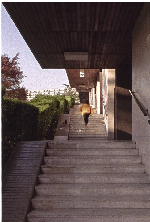
Kühne Ausmasse: Auf einem Kilometer reihen sich die Hauseingänge aneinander.
