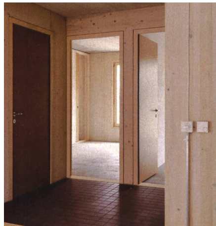
Holz, Zementböden, Betondecken und Keramikplatten fügen sich gut zusammen. Die Devise bei Abakus war einfaches und günstiges Bauen, unter anderem durch Low-tech-Lösungen und Aufputzleitungen.
