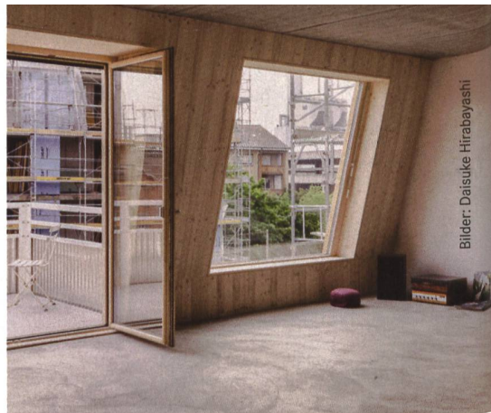
Holz, Zementböden, Betondecken und Keramikplatten fügen sich gut zusammen. Die Devise bei Abakus war einfaches und günstiges Bauen, unter anderem durch Low-tech-Lösungen und Aufputzleitungen.
