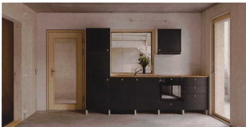
Die Küchen haben die Bewohnenden aus Ikea-Korpussen und eigens produzierten Linoleumfronten selber zusammengebaut.
