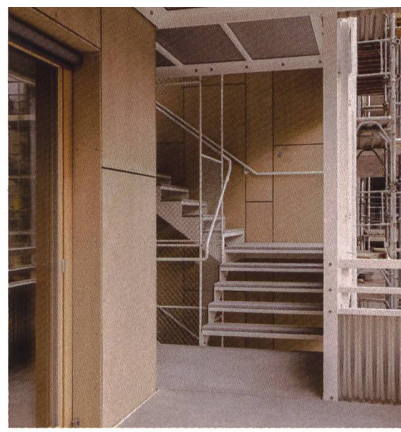
Das Treppenhaus ist verbindendes Herzstück des Hauses und dient als Begegnungsort. Die filigrane Stahlkonstruktion erlaubt Durchblicke. Die Wohnungen sind gegenüber dem Treppenhaus ebenfalls offen durch eingelassene Fenster und Türen mit Mattglas.
