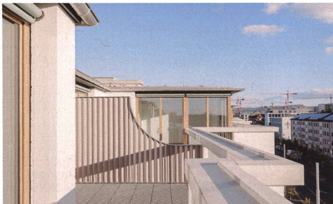
Im Erdgeschoss führen kleine Treppen von den Wohnungen in den Garten (links). Viele Balkone sind von zwei Zimmern aus zugänglich und verfügen über Aussenschränke, die von den Mietenden sehr geschätzt werden.
