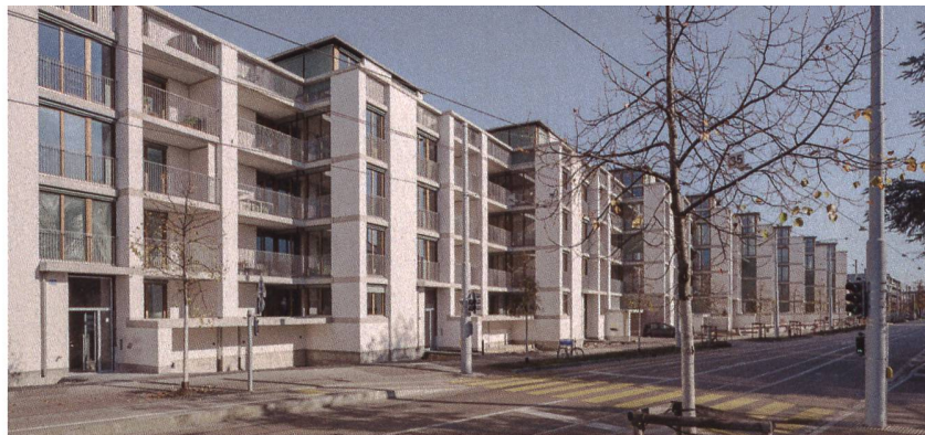
Zur Burgfelderstrasse wirkt die 200 Meter lange Gebäudezeile urban. Die Fassade wurde nicht verputzt, sondern geschlämmt: ein Abdichtungsverfahren, das besonders gut vor Feuchtigkeit schützt.
