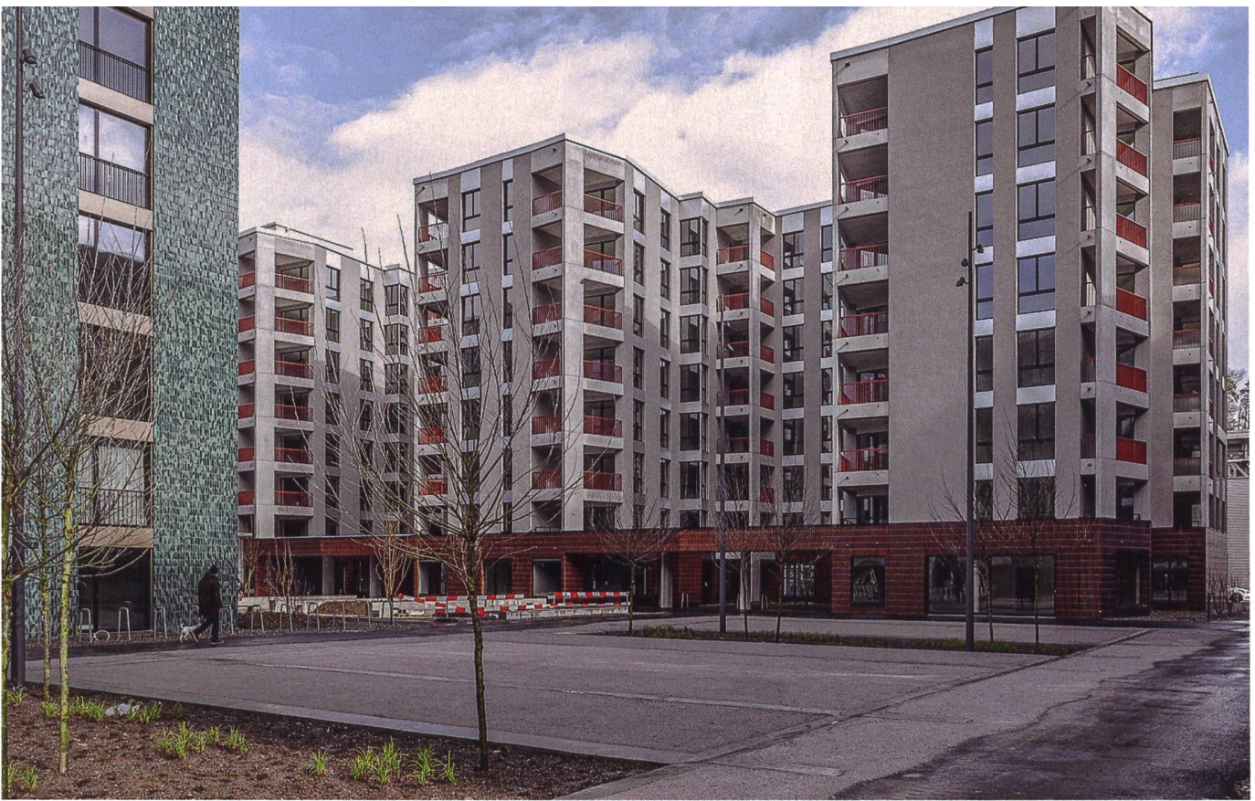
Die neue BEP-Siedlung Manegg ist sehr kompakt gebaut. Durch die kammförmige Struktur des langen Gebäudes entstehen drei Innenhöfe und ganz unterschiedliche Wohnungsgrundrisse.
