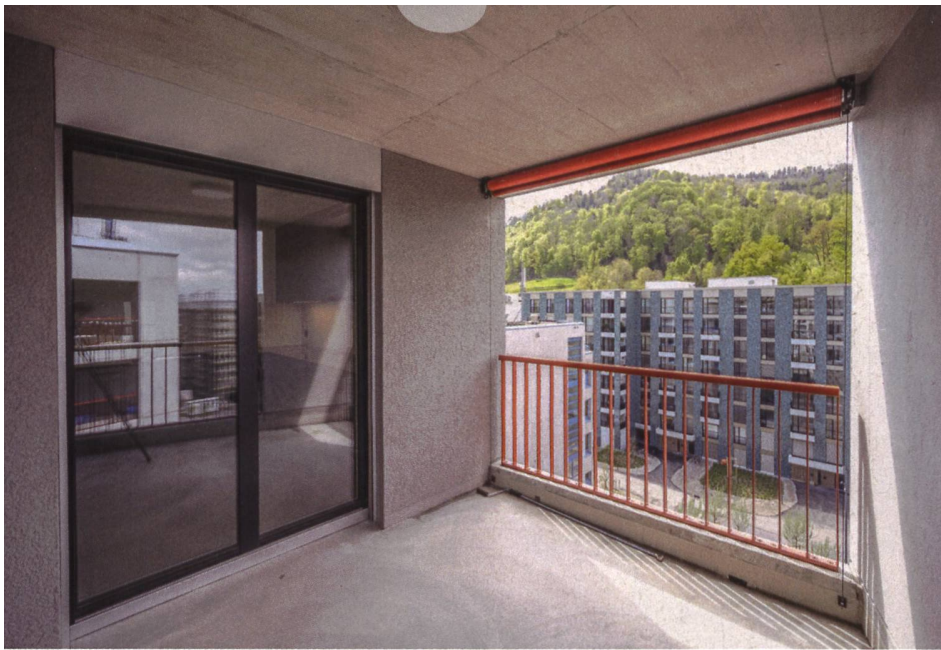
Balkone mit Aussicht zum Siedlungsteil mit Eigentumswohnungen und Uetliberg (oben links) beziehungsweise zur Strassenseite (rechts). Letztere haben Aussenschränke.
