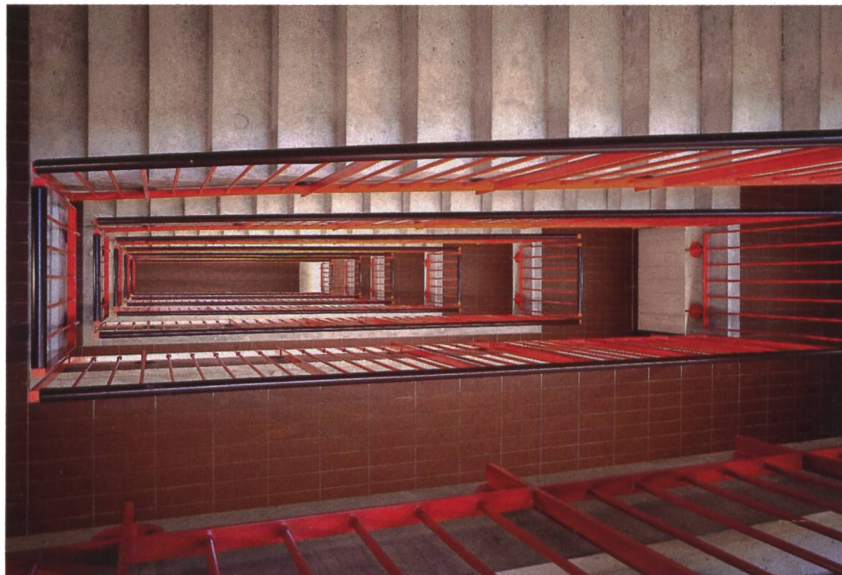
In den Treppenhäusern setzen farbige Geländer Akzente.
