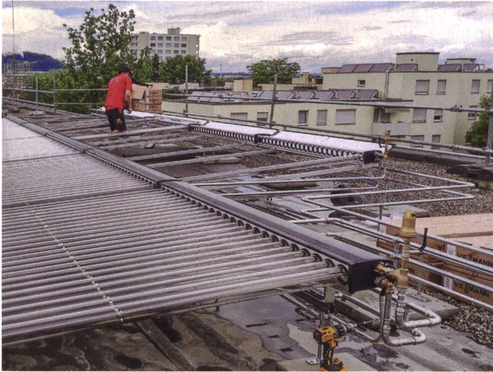
Vakuurröhrenkollektoren sind leistungsstärker als Flachkollektoren. Sie wurden auf einer Fläche von 90 Quadratmetern auf dem Dach eines Mehrfamilienhauses an der Siebenjurtenstrasse montiert.
