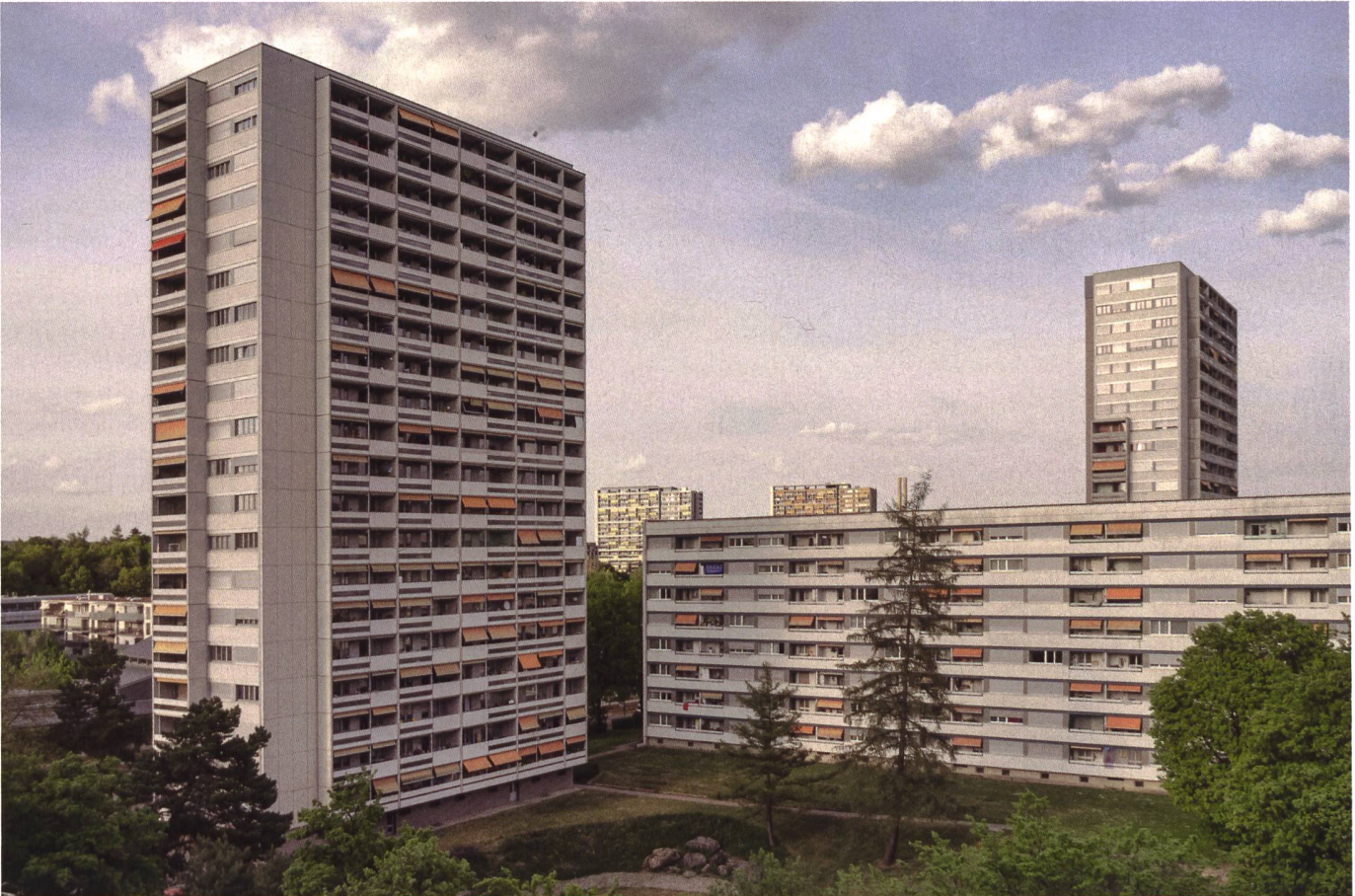
Das Tscharnergut wurde von 1958 bis 1965 in Bern gebaut und war eine der ersten Grosswohnsiedlungen der Schweiz. Es verfügte von Anfang an über Gemeinschaftsräume, Plätze und Grünflächen, die den Zusammenhalt der Bewohnenden stärkten - und das bis heute tun.
