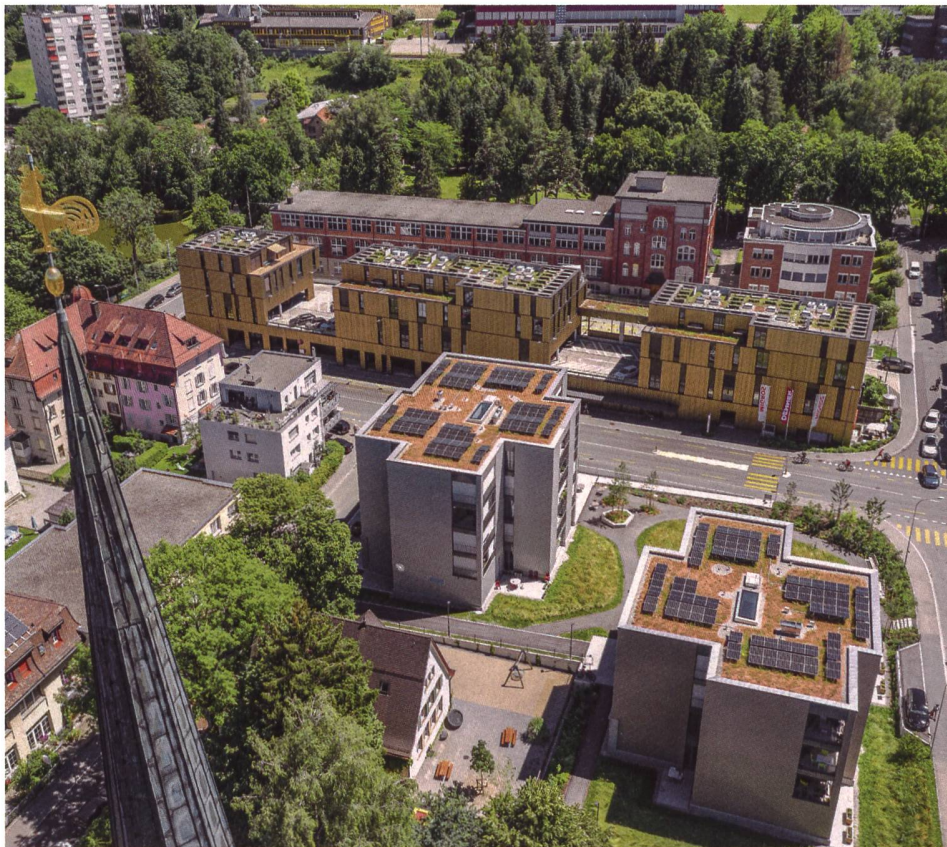
Die Alterssiedlung wurde auf Baurechtsland der evangelisch-reformierten Kirchgemeinde erstellt. Die Setzung der beiden Häuser (Bildmitte und rechts unten) ermöglicht einen grosszügigen öffentlichen Freiraum.
