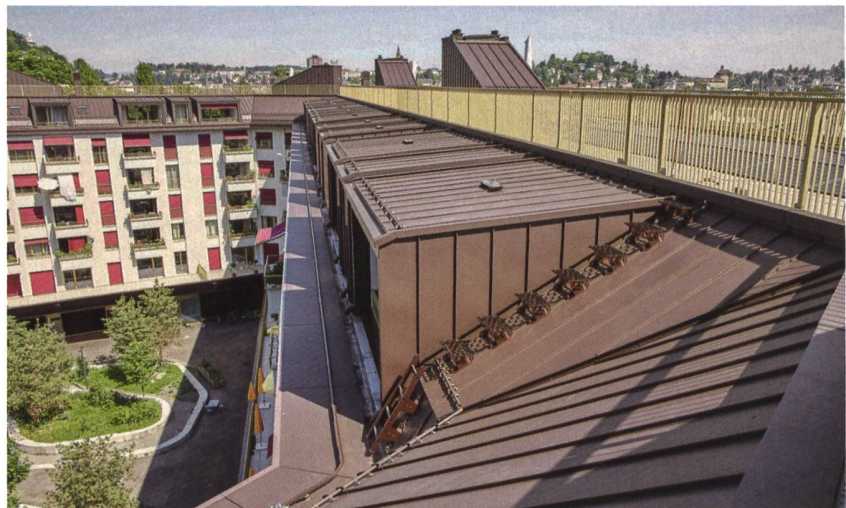
Bei Wartungsarbeiten erfolgt der Zutritt beim Himmelrich 3 immer über das Dach. Treppen erleichtern den Zugang. Alle Sicherungsmassnahmen wurden optisch unauffällig in die Gebäudearchitektur integriert.
