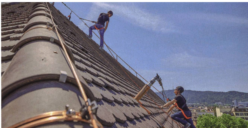
Beim kürzlich sanierten Volkshaus Zürich, das unter Denkmalschutz steht, wurden zur Absturzsicherung unauffällige Stahlstützen mit Seilen montiert.
