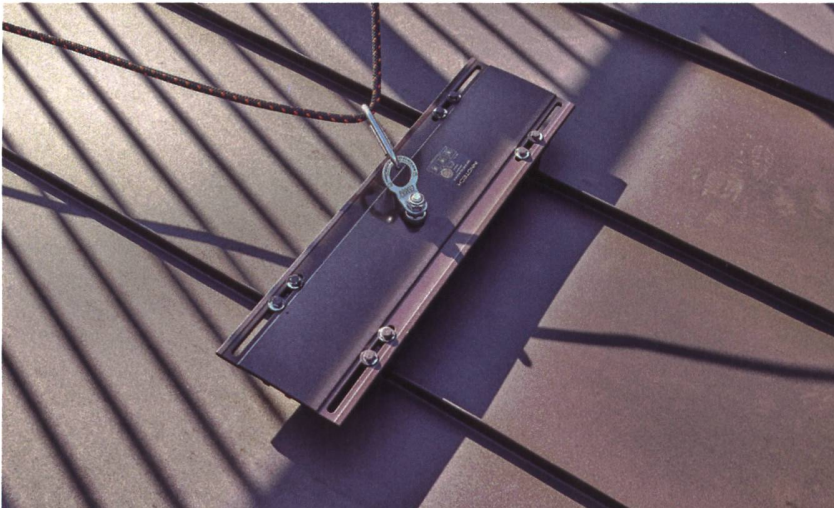
An fixen Haken, den Anschlagpunkten, können sich Mitarbeitende per Seil sichern.
