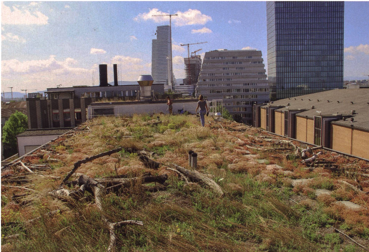
Beispiel einer Extensivbegrünung auf dem Gebäude des Departements Biomedizin in Basel. In einigen Gemeinden besteht für Flachdächer eine Begrünungspflicht. Mit einfachen Mitteln wie Totholzhaufen lassen sich diese ökologisch aufwerten.
