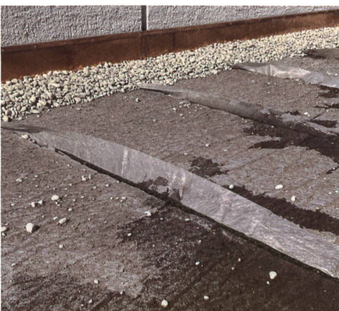
Impressionen vom Aufbau: Aufschüttungen und Abdichtung.
