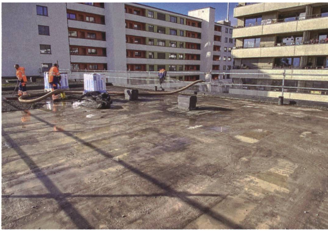
Flachdachsaniierungen stören den Alltag der Mietenden kaum. Das Absaugen und Hochblasen der Schutz- und Nutzschicht verursacht allerdings Lärm.
