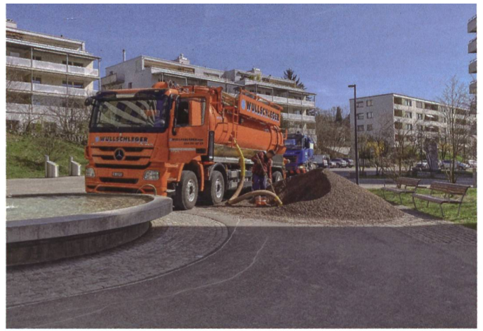
Flachdachsaniierungen stören den Alltag der Mietenden kaum. Das Absaugen und Hochblasen der Schutz- und Nutzschicht verursacht allerdings Lärm.
