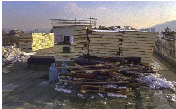
Beim Rückbau wurden noch brauchbare Platten gesammelt. Vierzig Prozent wurden wiederverwendet.
