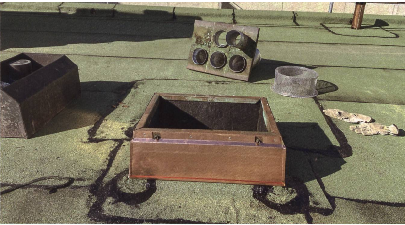
Qualitätsarbeit ist bei Flachdächern vor allem bei An- und Abschlüssen wie Lüftungen oder Geländerpfosten wichtig. Hier kommt es am häufigsten zu Feuchtigkeitsschäden.
