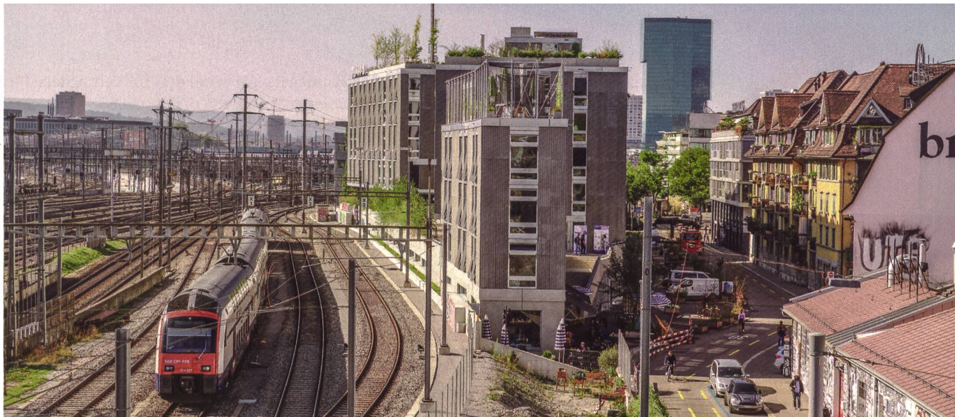
Das Areal Ecke Lang-/Zollstrasse in Nähe des Zürcher Hauptbahnhofs gehörte früher Stadt und SBB. 2014 konnte es die Genossenschaft Kalkbreite kaufen und baute das Zollhaus (Mitte). Künftig wollen die SBB mit der Abgabe von Land im Baurecht preisgünstiges Wohnen ermöglichen.
