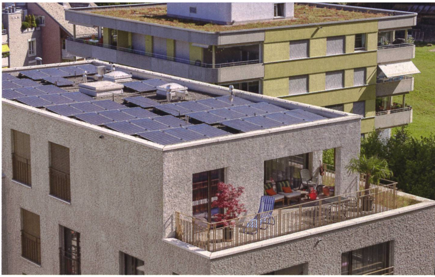
Um ihr Klimaziel zu erreichen, will die ABL unter anderem wo immer möglich die maximale Kapazität an Solaranlagen zubauen. Die Siedlung Obermaihof in Luzern ist bereits mit einem Solardach versehen.
