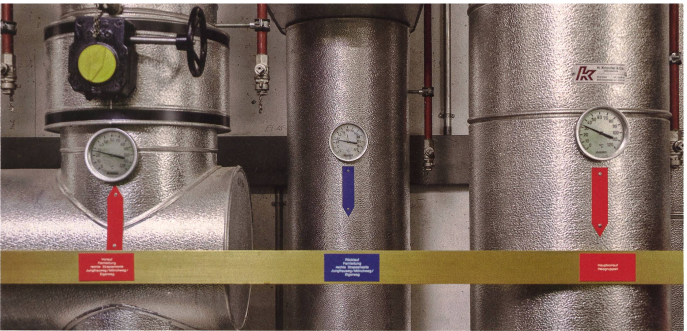
Bei der Allgemeinen Baugenossenschaft Luzern (ABL) werden neunzig Prozent der Wohnungen noch fossil beheizt. Deshalb werden jetzt die Heiztemperaturen auf 21 Grad gesenkt. Innert zehn Jahren will die Genossenschaft klimaneutral sein. Auf dem Bild die Heizzentrale der Siedlung Breitenlachen.
