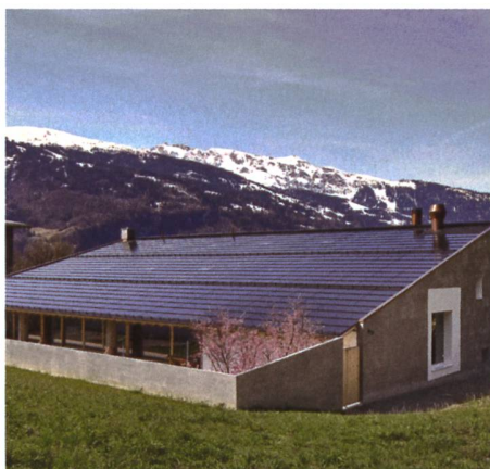
Die ganzflächig integrierte Photovoltaikanlage «Sunskin Roof» von Eternit erfüllt sowohl die architektonischen als auch die ästhetischen Anforderungen der Heimatschutzgemeinde Fläsch und produziert jährlich 179 700 kWh.
