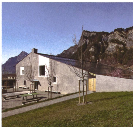
Die ganzflächig integrierte Photovoltaikanlage «Sunskin Roof» von Eternit erfüllt sowohl die architektonischen als auch die ästhetischen Anforderungen der Heimatschutzgemeinde Fläsch und produziert jährlich 179 700 kWh.
