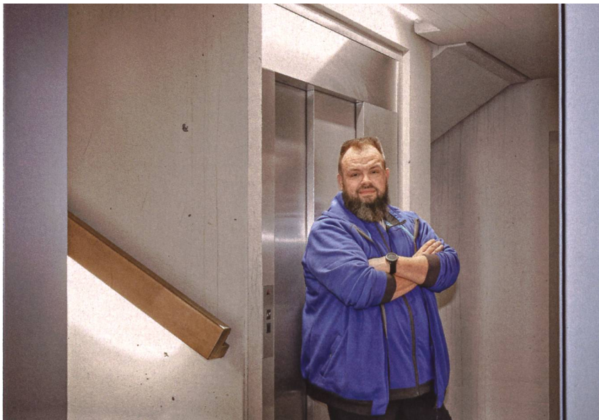
In der Siedlung Luegisland wurden in den Treppenhäusern intelligente LED-Leuchten montiert. Der Energieverbrauch ist um achtzig Prozent gesunken. Ein weiterer Pluspunkt: Die Hauswarte haben kaum mehr Aufwände für Reparaturen.
