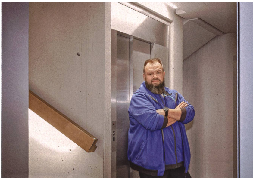
In der Siedlung Luegisland wurden in den Treppenhäusern intelligente LED-Leuchten montiert. Der Energieverbrauch ist um achtzig Prozent gesunken. Ein weiterer Pluspunkt: Die Hauswarte haben kaum mehr Aufwände für Reparaturen.
