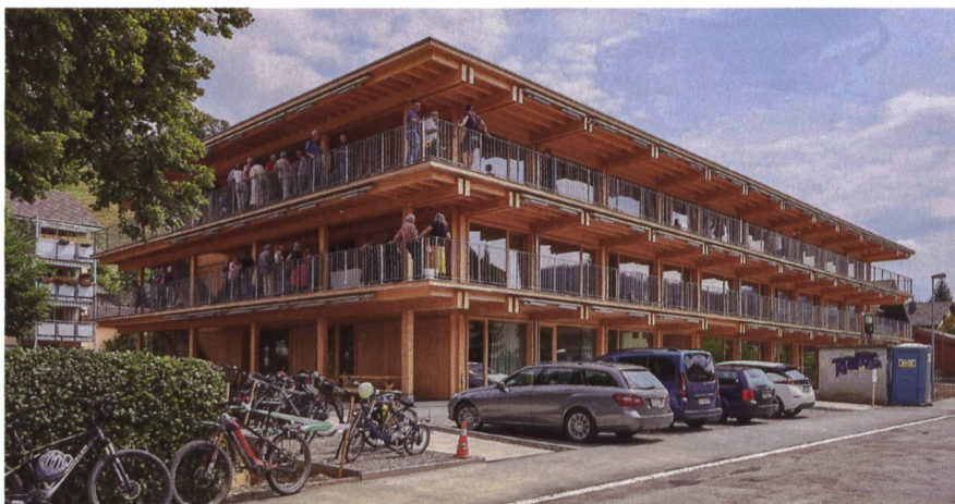
Auf eine Einstellhalle wurde verzichtet – für Autobesitzerinnen und -besitzer stehen nur wenige Parkplätze vor dem Haus zur Verfügung.
