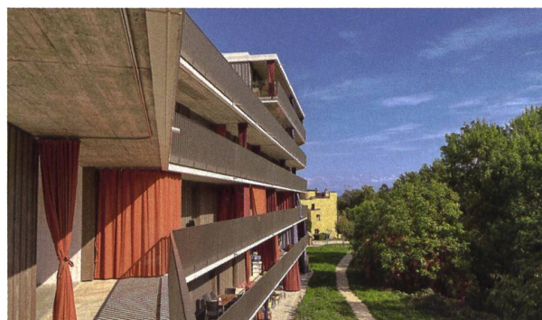
Auffällig sind die bunten Aussenvorhänge auf den Laubengängen. Sie dienen als Schattenspender.
