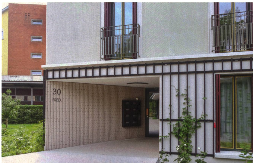
Die Keramikplatten bei den Hauseingängen sind nicht nur widerstandsfähig, sondern auch ein Gestaltungselement. Im Erdgeschoss sind an der Fassade Pflanzenspalier angebracht. Im rechten Bild sind ganz links die Vertikalmarkisen zu sehen, die in den Loggien für Sonnenschutz sorgen.
