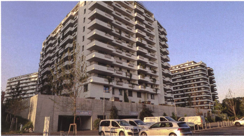
Am Südrand der Siedlung stechen die begrünten Fassaden der Tiefgaragen ins Auge. Die Garagen wurden mehrstöckig konzipiert, damit die Versickerungsflächen frei bleiben.
