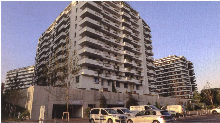
Am Südrand der Siedlung stechen die begrünten Fassaden der Tiefgaragen ins Auge. Die Garagen wurden mehrstöckig konzipiert, damit die Versickerungsflächen frei bleiben.
