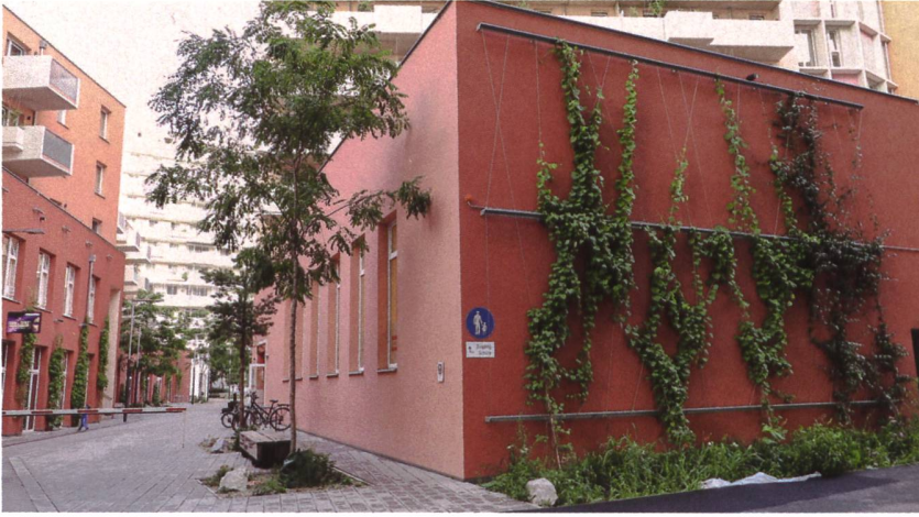
Die 250 neu gepflanzten Bäume wirken teilweise noch bescheiden. Noch üppiger wachsen könnten auch die Pflanzen an den Fassaden in den schattigeren Gassen des Quartiers.
