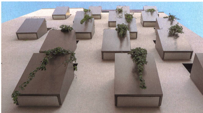
Begrünte Fassaden, Loggien und Balkone mit baulich integrierten Pflanztrögen tragen im neuen Stadtquartier künftig zum hohen Begrünungsfaktor bei.
