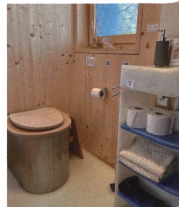
Wasserkreisläufe spielen eine wichtige Rolle: Das gereinigte Grauwasser wird zum Bewässern des Dachgartens genutzt, die Nährstoffe für die Pflanzen stammen von den aufbereiteten Fäkalien.
