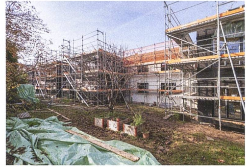
Die Aufbauten ruhen auf je vier Schraubfundamenten. Die dünnen Stahlstützen kommen ohne Betonfundament aus. Weil keine Aushubarbeiten nötig waren, dauerte die Montage nur drei Tage.
