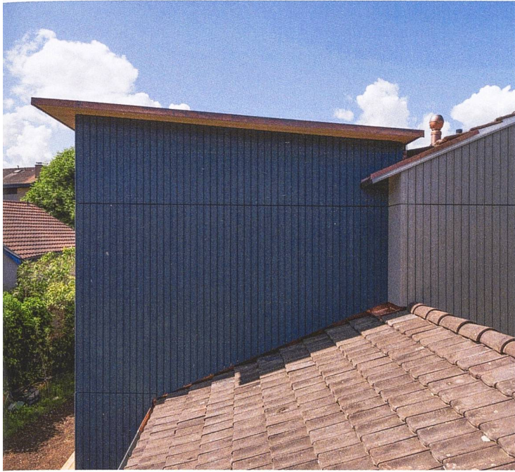
Die zweigeschossigen Anbauten bestehen aus vorgefertigten Holzelementen. Die unteren Wohnungen führen direkt in den Garten, in den oberen Geschossen sorgt nun eine erhöhte Holzdecke für mehr Luft.
