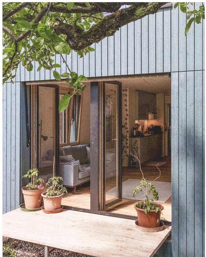
Die zweigeschossigen Anbauten bestehen aus vorgefertigten Holzelementen. Die unteren Wohnungen führen direkt in den Garten, in den oberen Geschossen sorgt nun eine erhöhte Holzdecke für mehr Luft.
