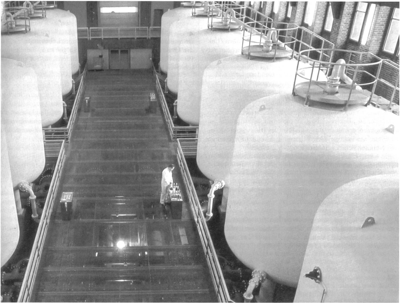
Die Wasserwerke dürfen nicht zu Aufbereitungsfabriken verkommen: Mit Aktivkohle gefüllte Filterkessel in einem Kölner Wasserwerk.
