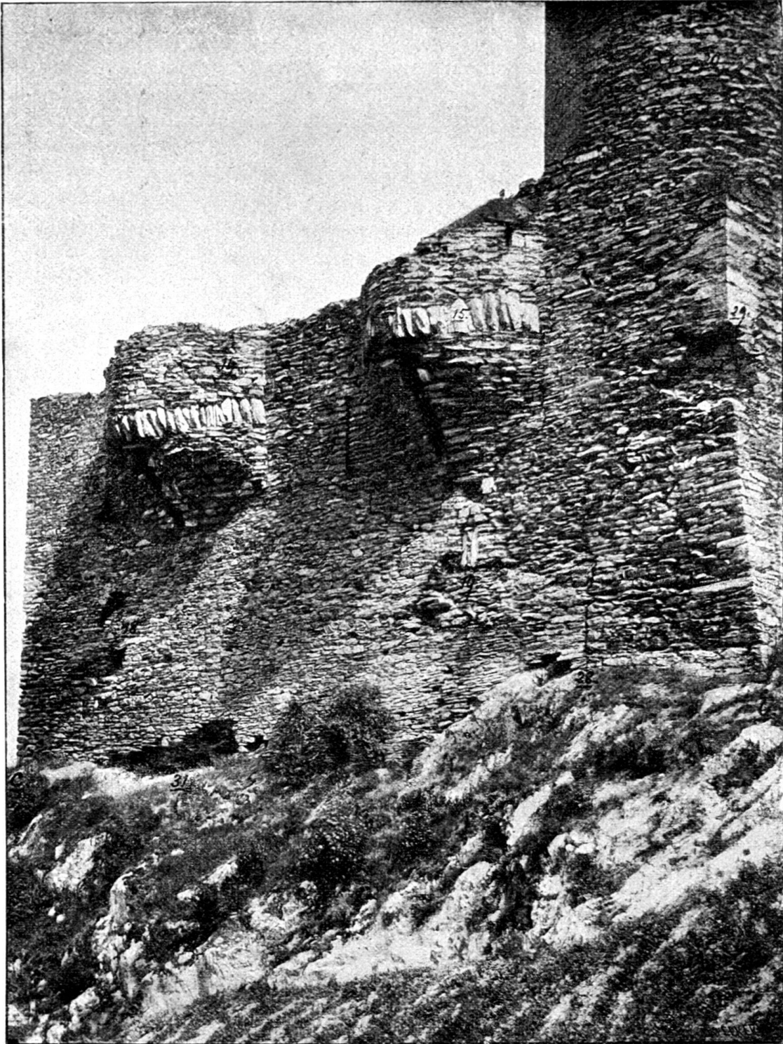
Fig. 51. Bâtaia. Face Nord-Ouest.
